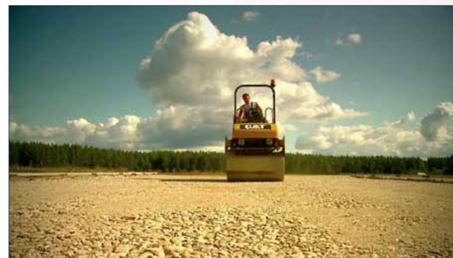
Budowa boiska „Orlik” w Monkiniach
